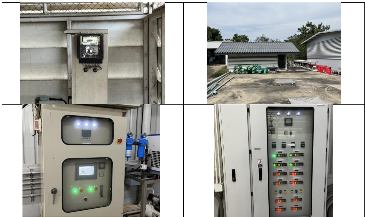
รูปที่ 2-12 การติดตั้งมิเตอร์ไฟฟ้าของระบบบำบัดน้ำเสียและการควบคุมการทำงานของระบบบำบัดน้ำเสีย
