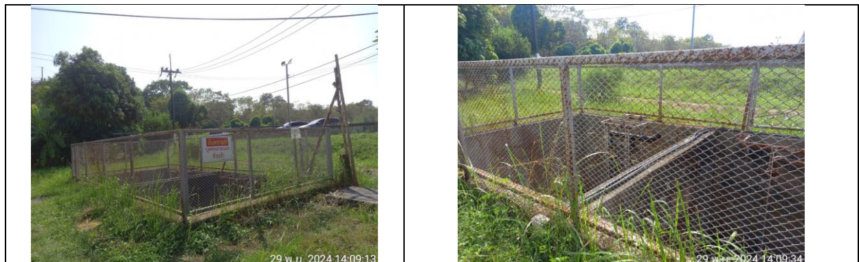
บ่อพักน้ำเสียรวมก่อนเข้าสู่ระบบบำบัดน้ำเสีย
